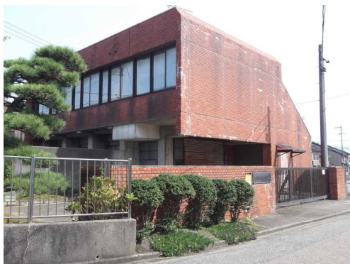
写真47：内川浄化排水機場 1
