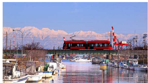
写真39 : 万葉線内川橋梁
