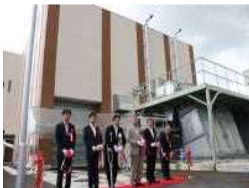
写真41：中央排水機場
