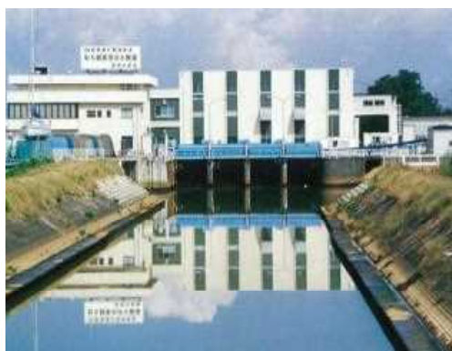
写真43：東部排水機場
