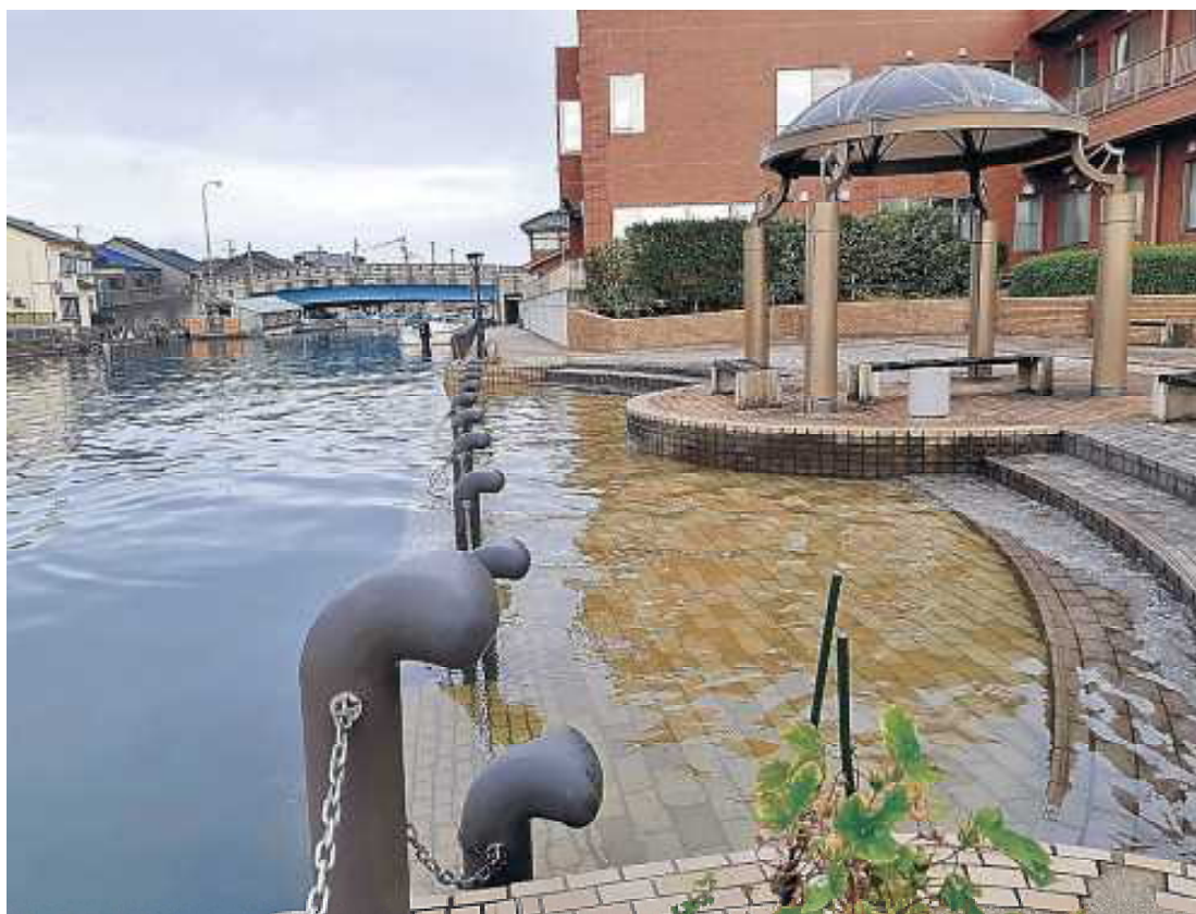
写真68：2004年(平成16年) 高潮で浸水した内川沿い＝10月20日、山王町内川地内
