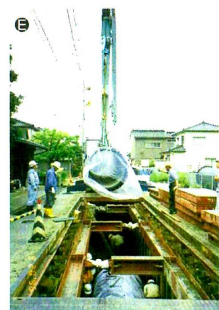
写真60： 導水管敷設状況
