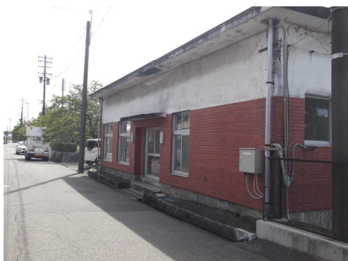
写真45：荒屋ポンプ場 1
