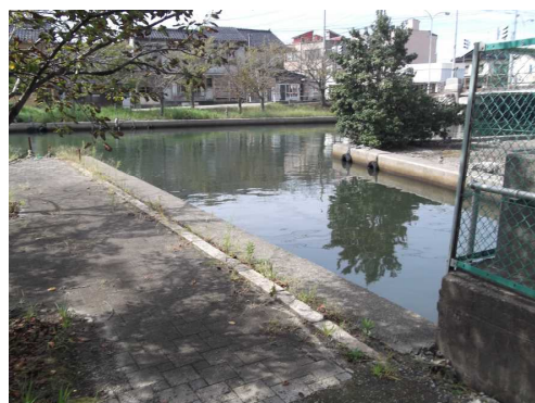
写真46：荒屋ポンプ場 2
