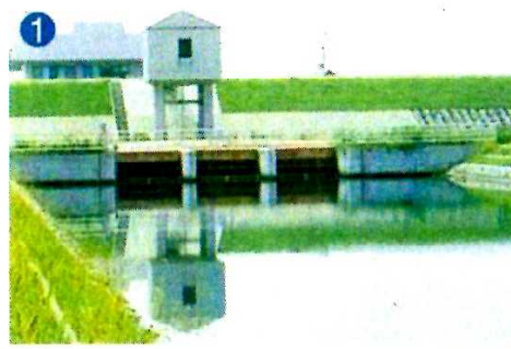
写真57：庄川取水状況
