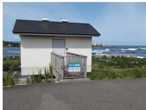
写真48：内川浄化排水機場 2
