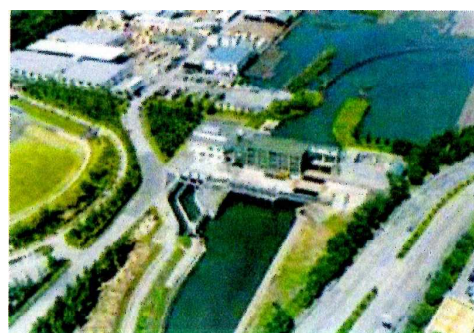
西部排水機場
