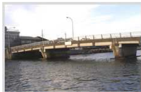
写真34：奈呉の浦大橋
