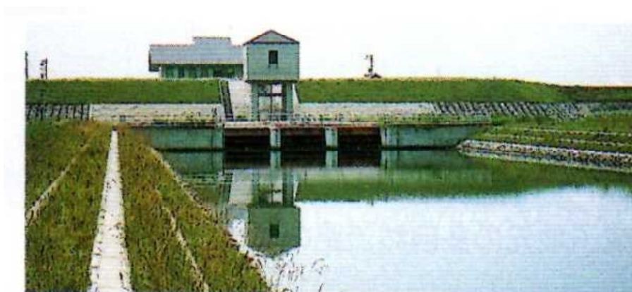
内川流域浄化揚水機場取水樋管
